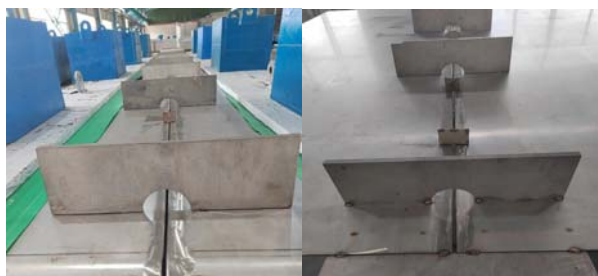
附图五十四:马板固定、配重块防止变形
