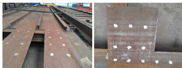
附图四十三:栓钉焊接位置打磨干净
