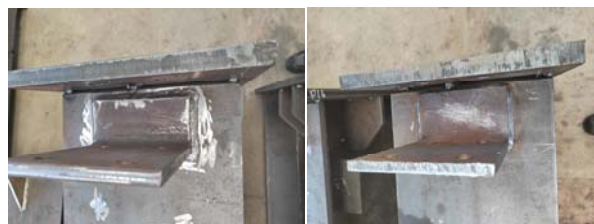
附图四十四:先组对檩托板后焊接全熔透焊缝
