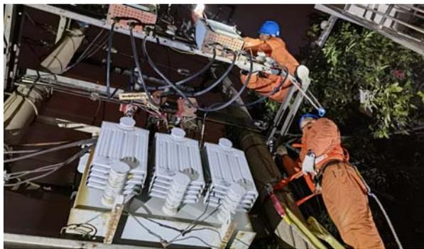
南京石城共产党员服务队在南京建邺区沿河五村小区进行变压器低压开关故障紧急消缺
